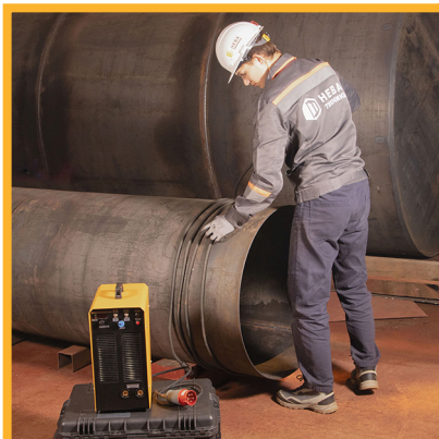
Рисунок 4 – Монтаж размагничивающей обмотки
