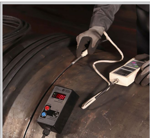
Рисунок 7 – Монтаж размагничивающей обмотки на стык труб
