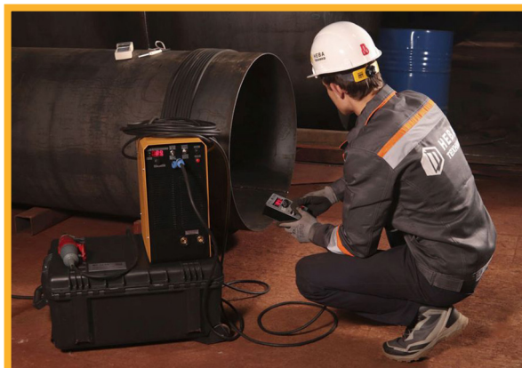
Рисунок 6 – Размагничивание торца трубы
